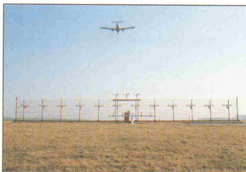
Bild 2. Die Landekurs-Antenne für eine Rollbahn auf dem Flughafen Hannover-Langenhagen; der technische Aufwand ist enorm!
